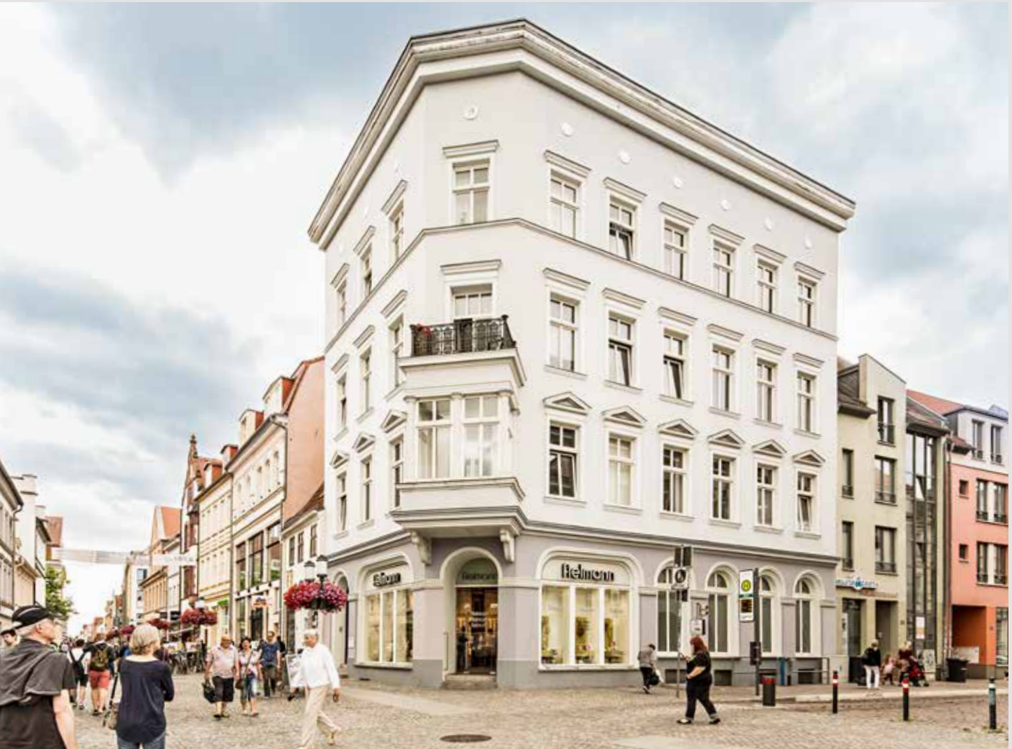
Greifswald, Lange Straße
